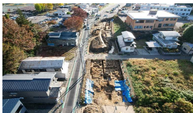
【進捗状況】 八幡根岸線（横手市）
